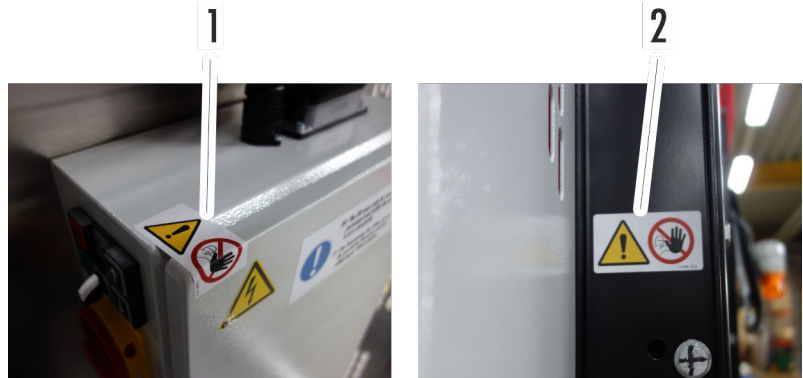
Abb. 6: Siegel Schaltschrank und Überlast
